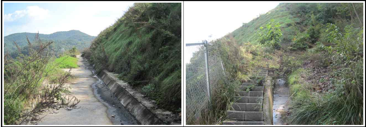
【그림 20.3.3】 배수시설 전경
