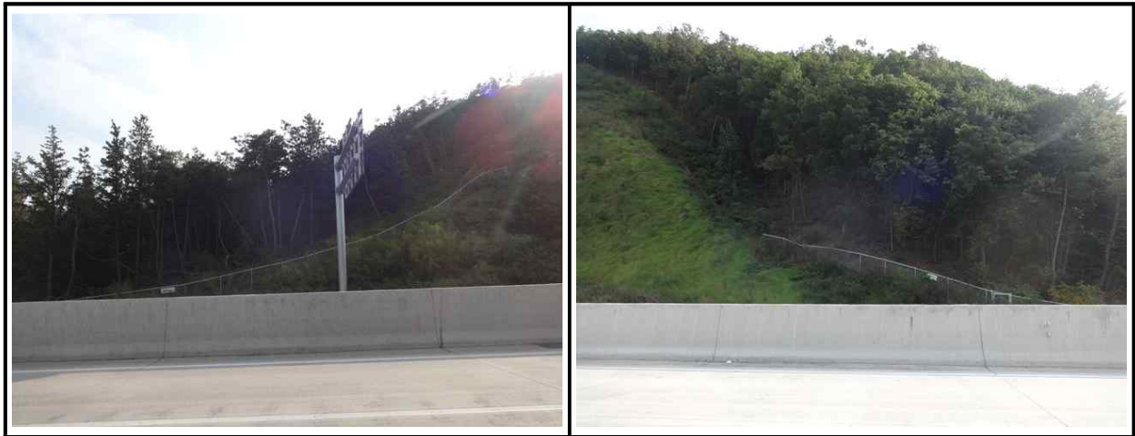
【그림 20.3.1】 상부자연사면 전경
